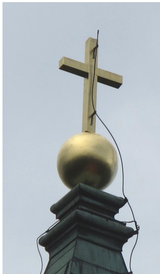
Bild 8: Tornets hörnklot var i gott skick och behövde endast rengöring, 5 juni 2015.
