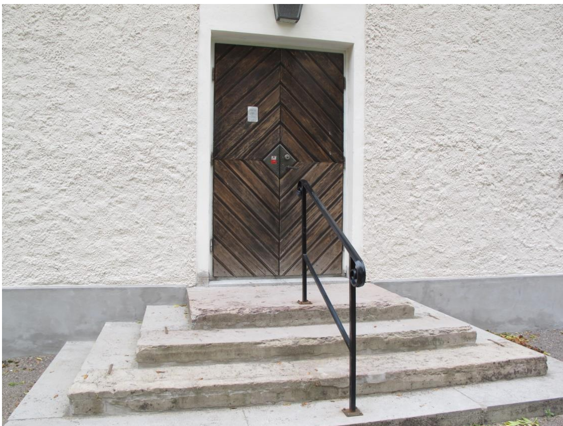
Bild 14: Södra porten före åtgärd, 8 oktober 2015.
