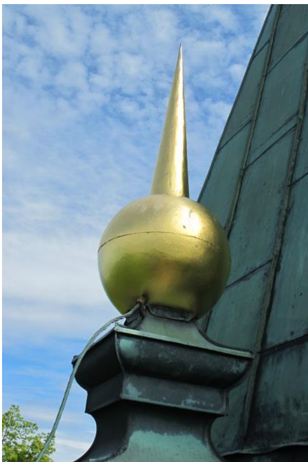
Bild 8: Tornets hörnklot var i gott skick och behövde endast rengöring, 5 juni 2015.
