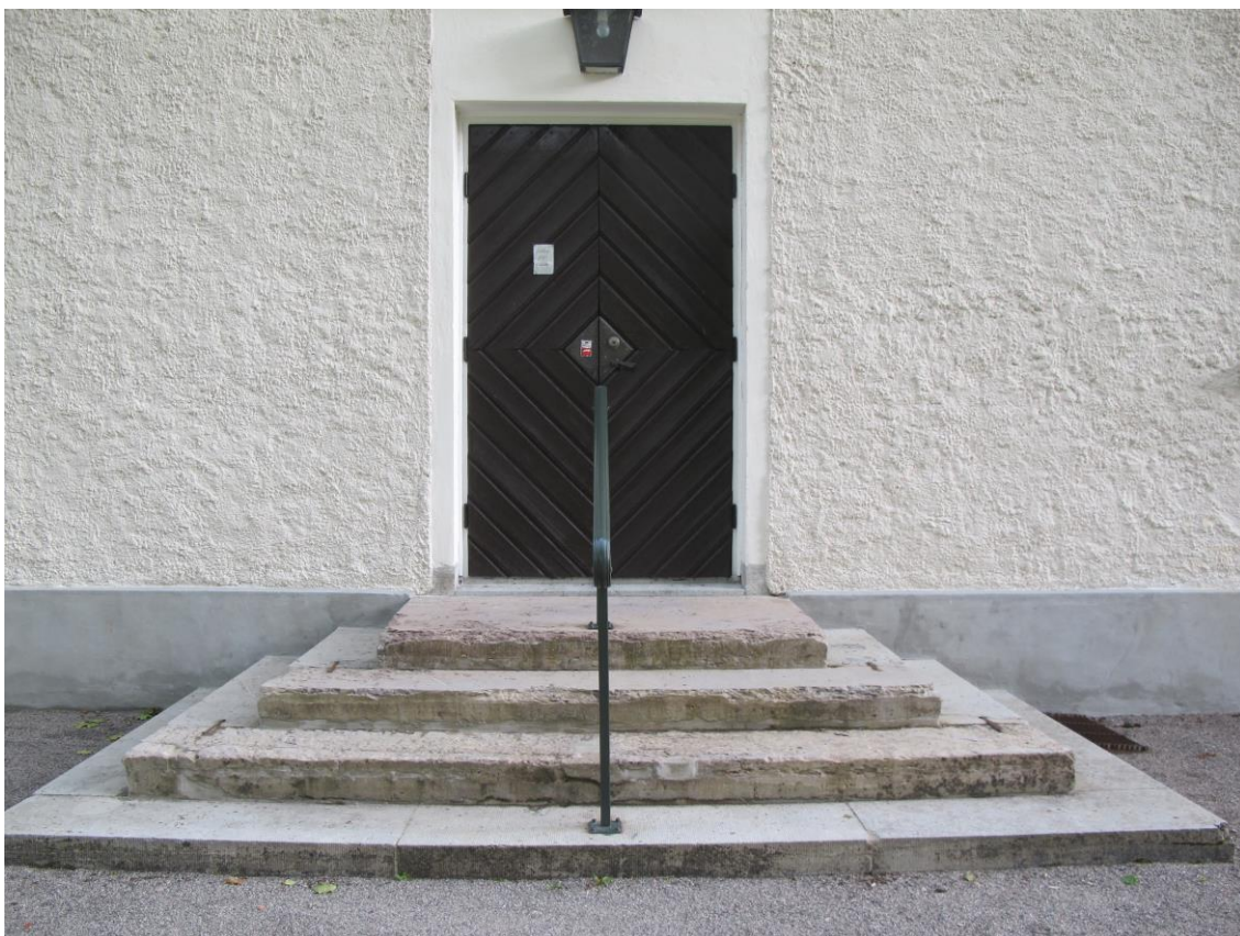
Bild 15: Södra porten har målats och kalkstenstrappan har lagats på vissa ställen, 4 augusti 2016.
