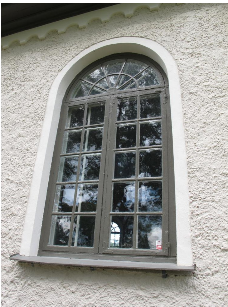
Bild 7: Fönster efter målning, 4 augusti 2015.
