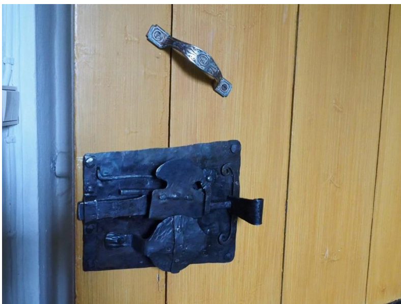
Bild 24: Sakristians dörr försågs med ett fallregellås av smide, 19 maj 2016. Foto: Börje Lindström, Arkitektur och Byggnadsvård AB.
