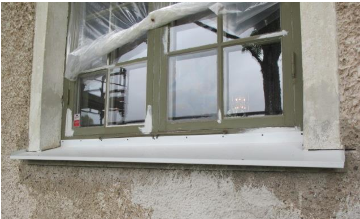
Bild 6: Fönster under åtgärd. Nytt fönsterbleck av plåt monterades på norra sidan, 24 juni 2015.
