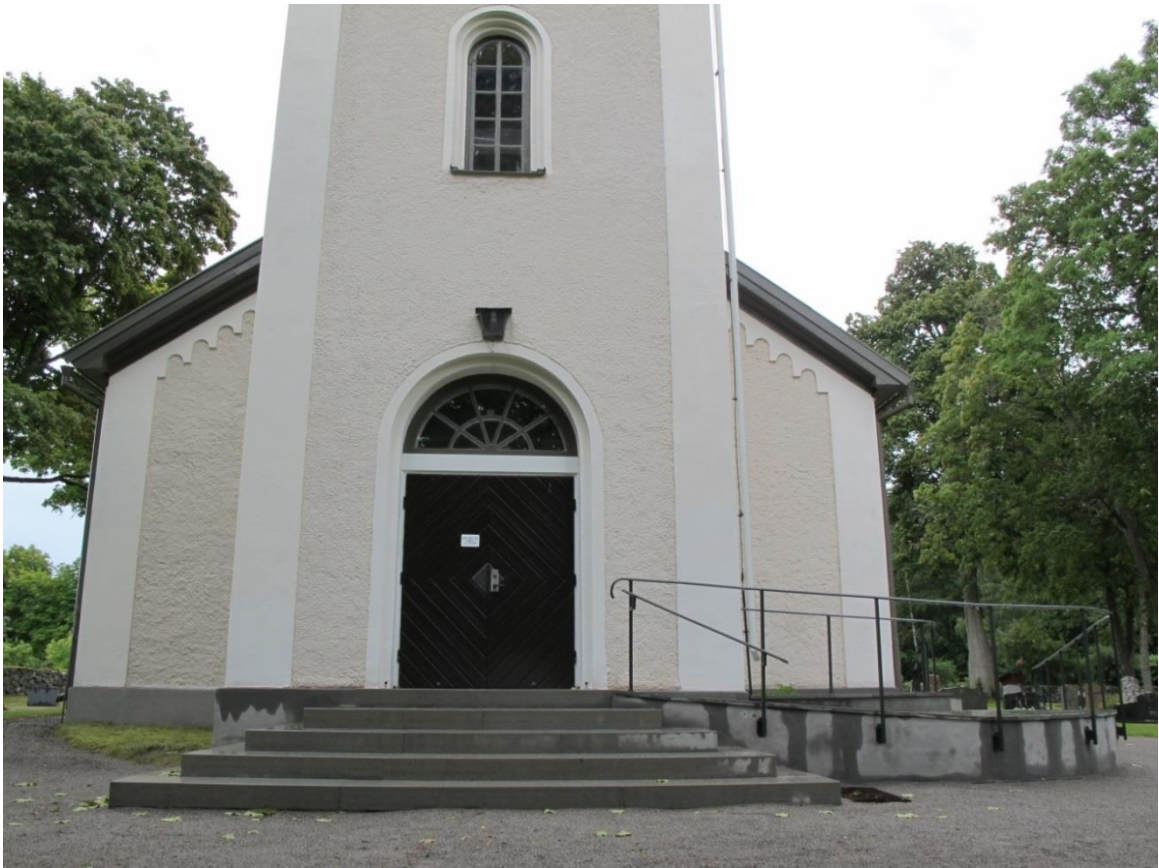
Bild 17: Kyrkan efter putsarbeten, 4 augusti 2016.
