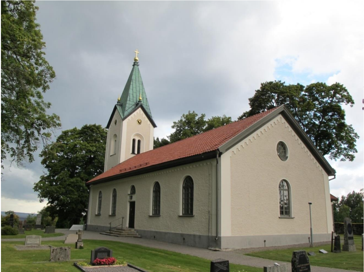
Bild 16: Kyrkan efter putsarbeten, 4 augusti 2016.
