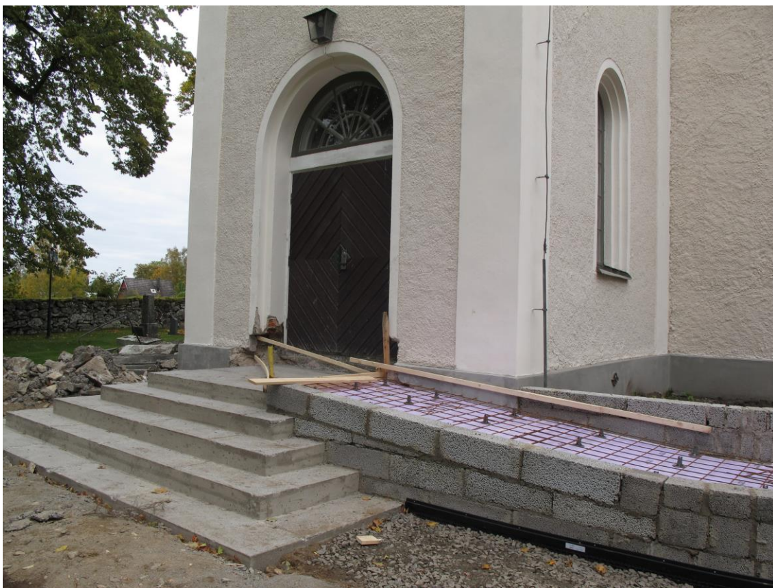
Bild 13: Kyrkan under åtgärd. En ny trappa av kalksten har lagts utanför västra porten. Rampen är under uppförande, 8 oktober 2015.
