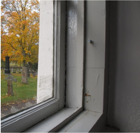
Bild 20: Karm före målning. Innerbåge är bortmonterad, 22 oktober 2015.
