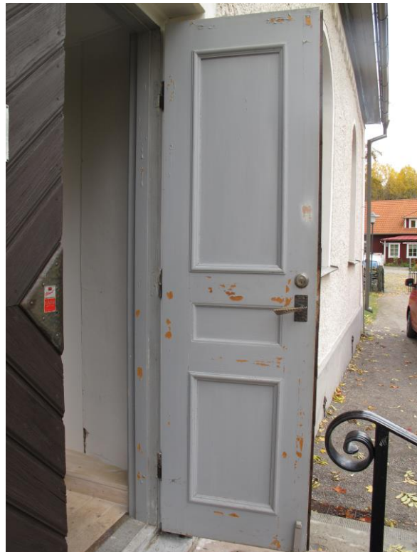
Bild 22: Södra portens insida före åtgärd, 22 oktober 2015.
