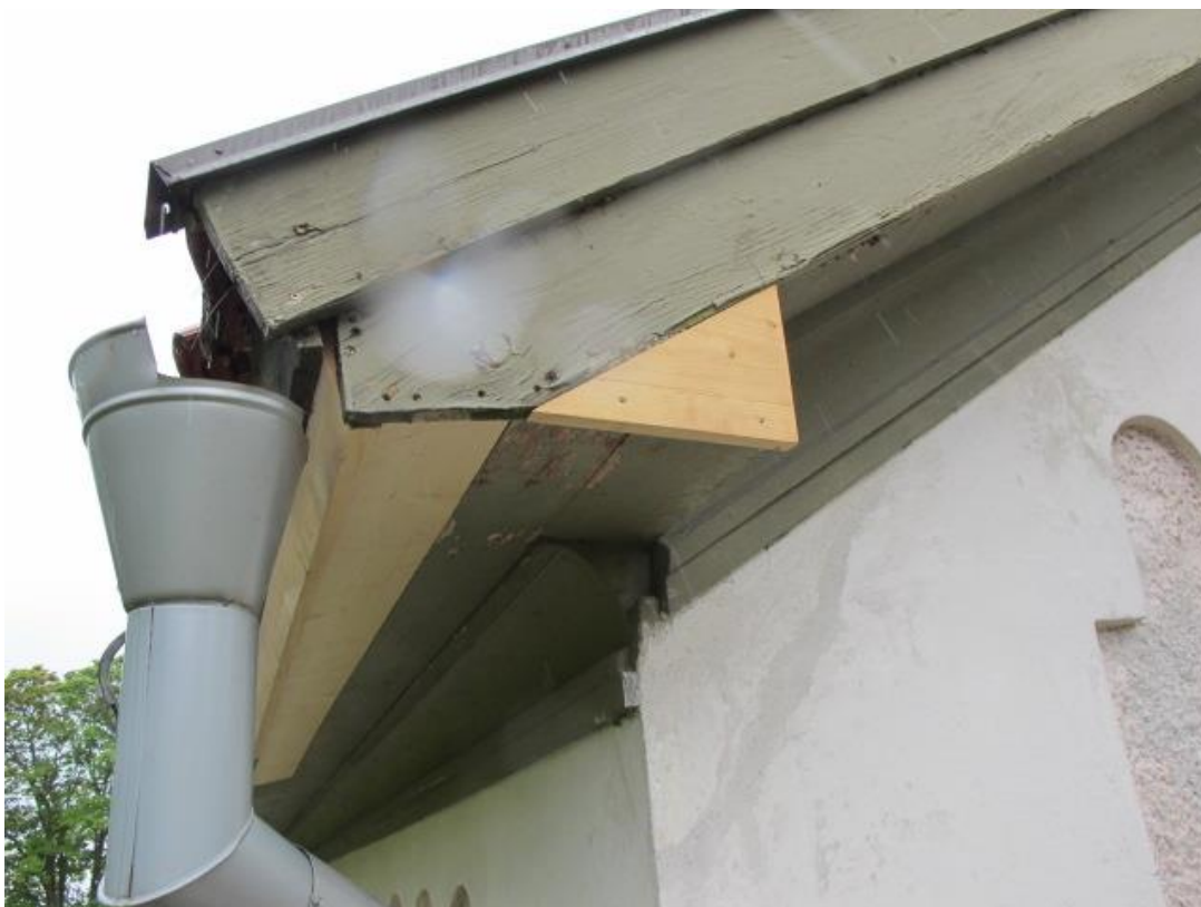
Bild 5: Kyrkan under åtgärd. Takfotens rötskador lagades, 24 juni 2015.
