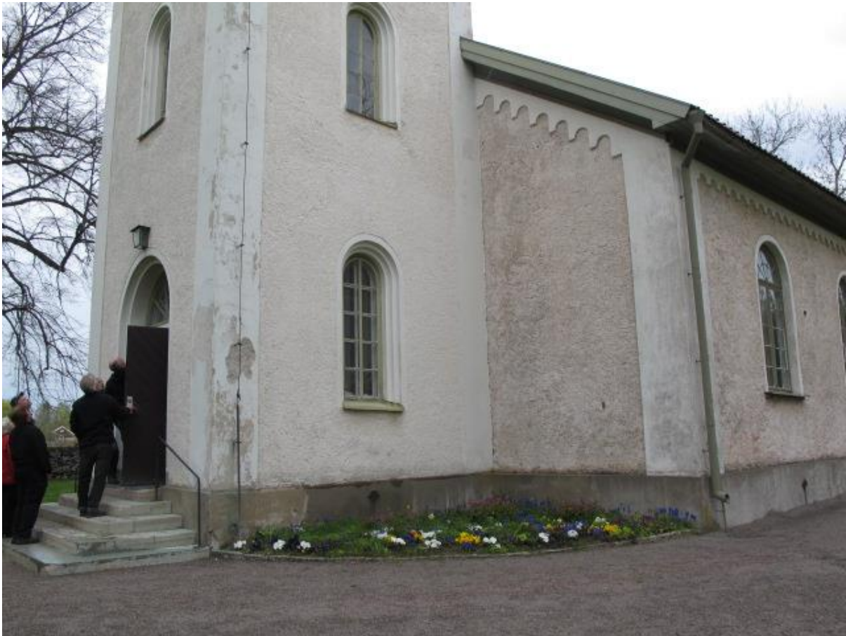
Bild 3: Tiveds kyrka före åtgärder, 12 maj 2015.
