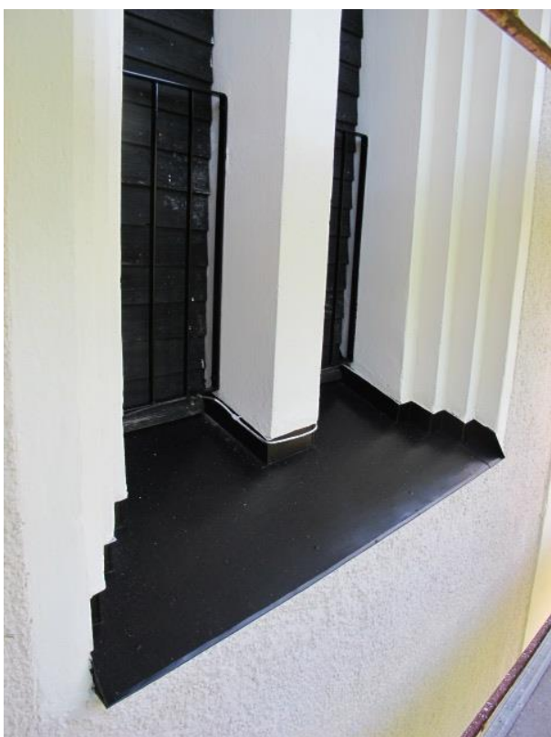
Bild 10: Tornluckor, smidesräcke och plåt efter tjärstrykning och målning. 13 augusti 2015.
