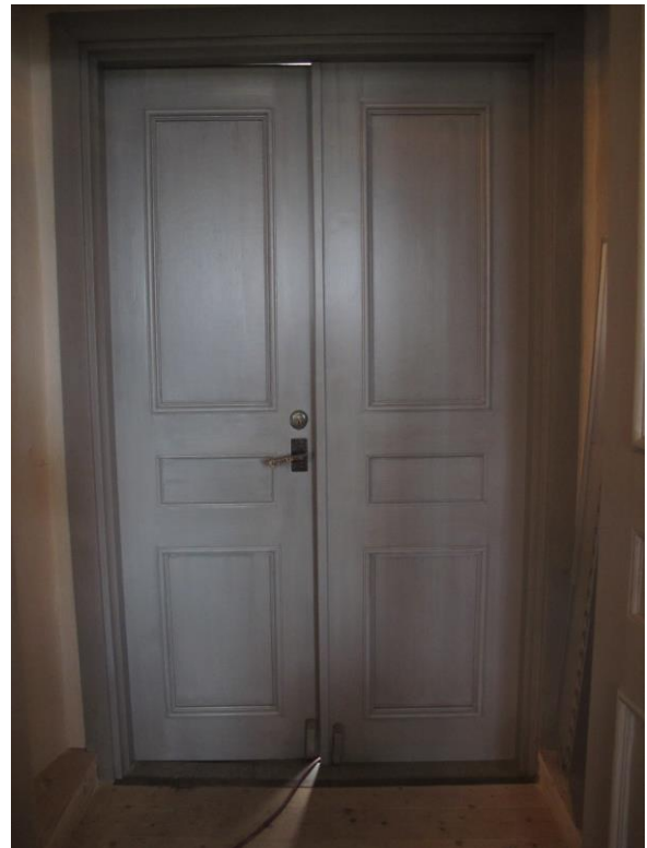
Bild 23: Södra portens insida efter målning med strålasering, 18 november 2015.
